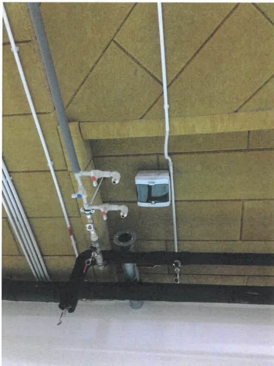
Příklad umístění ovládacích prvků na stropě pod stěnou.
