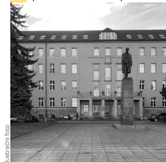
02 pohled na hlavní vstup
