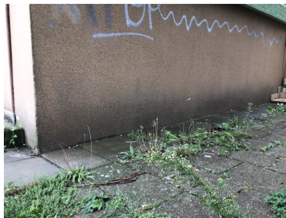
Foto č.6 – pohled na štítovou stěnu, kde dochází k hromadění dešťových vod a zasakování podél stěn
