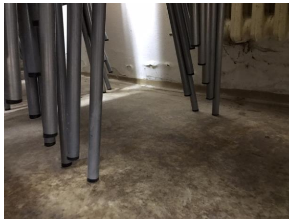
Foto č.2 – degradace povrchových úprav nad podlahou suterénu řešeného prostoru
