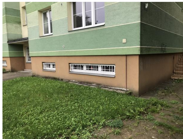
Foto č.4 – venkovní pohled na řešenou část suterénních prostor, viditelná degradace marmolitové úpravy soklové části v těsné blízkosti okapového chodníku
