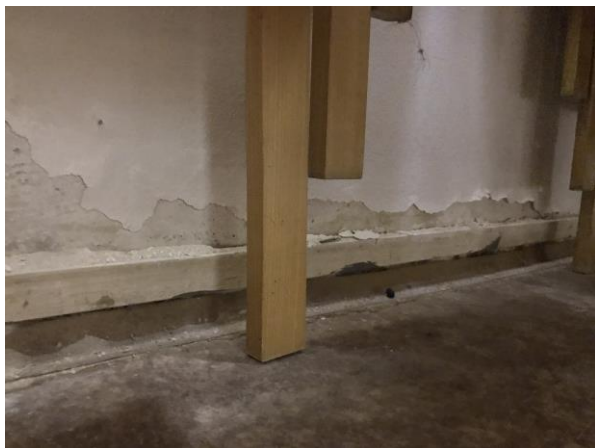
Foto č.1 – degradace povrchových úprav nad podlahou suterénu řešeného prostoru
