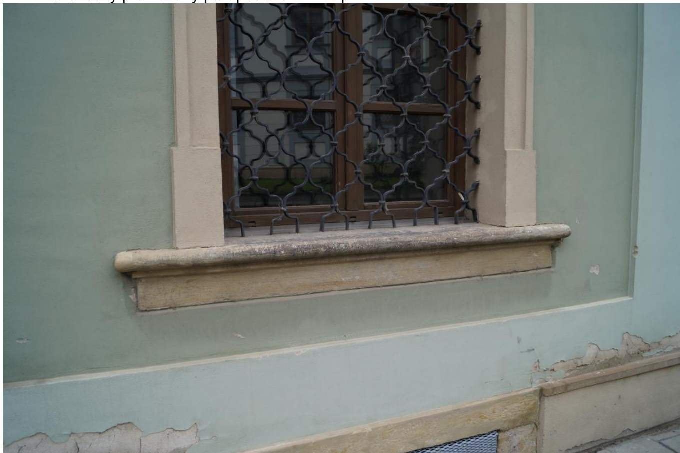
K4- Pískovcový obklad soklu s krycí římsou s okapnicí
