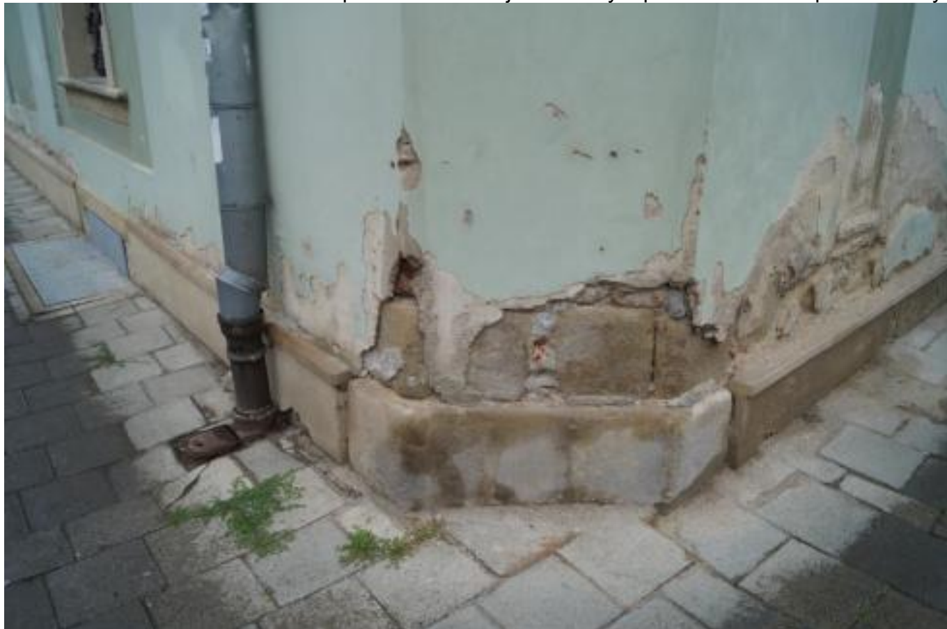
K6 - Pískovcové bosované nároží při levém nároží jižní fasády a pravém nároží západní fasády
